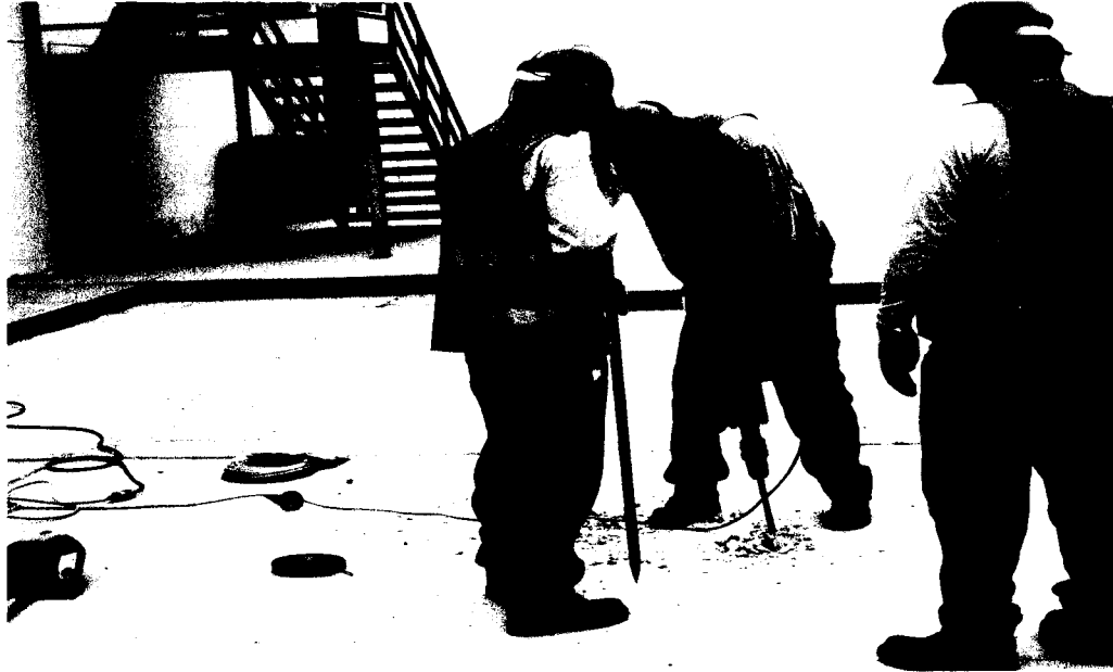
Fotografía N° 03 Partidas de demolición con equipo liviano (Rotomartillo) y trabajadores con sus respectivos EPP
